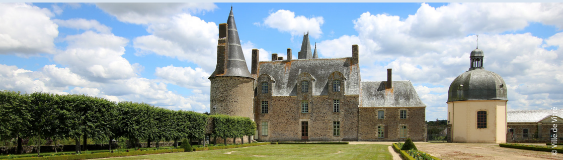
Façade du château des Rochers
