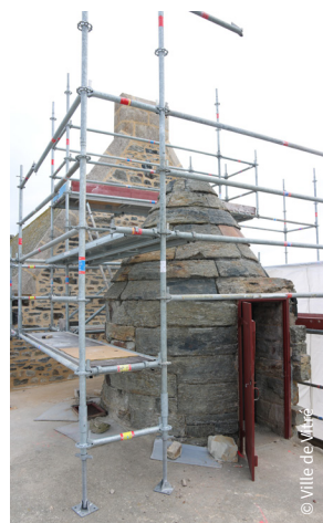
Chantier de la tour Montafilant
